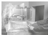
3. EBK-A се фиксира симетрично спрямо отвора в стената. За осигуряване на достъп до управляващия механизъм и ревизионния отвор, разстоянието между стената и външния ръб на клапата трябва да е 170 mm
