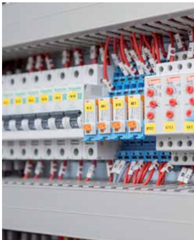
Логичен, подреден и „акуратен“ монтаж в електрическия шкаф
