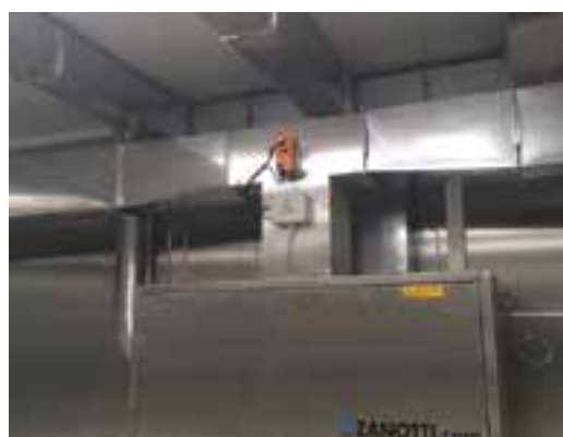
Система за обмен на въздуха със стоманени въздуховоди с цинково покритие, допълнена с конуси и регулируеми смукателни устройства
