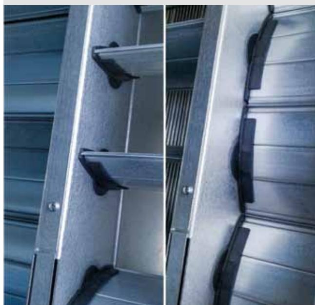
За осигуряване на по-висока ефективност и различни режими на работа на централите (обезскрежаване, свободно охлаждане и рециркулация), към рекуператорите се добавят байпасни и рециркулационна клапи.
